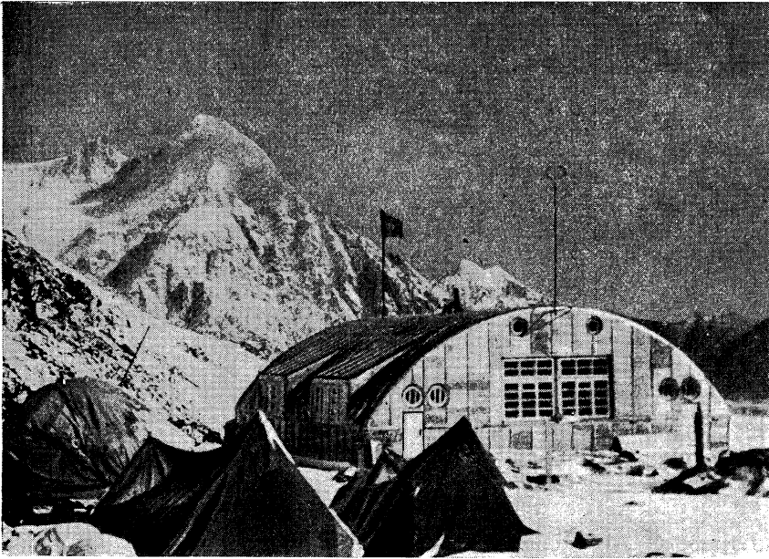
Метеостанция на леднике Федченко. В здании, форма которого рассчитана на сопротивление свирепым ветрам высокогорья, живет и трудится дружный коллектив советских людей, систематически изучающих климат Памира.
